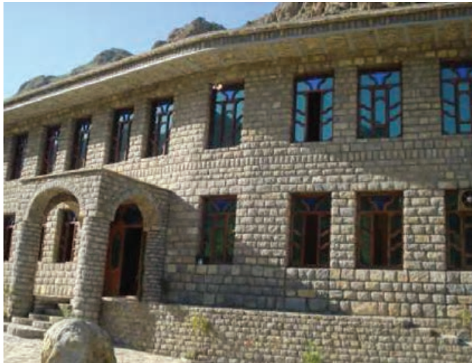
شکل ۳۳-۱- نمایی از معماری سنگی متناسب با آب و هوای منطقه (هه‌ورامان)
