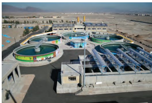
شکل ۱۳-۴- تصفیه خانه آب زاهدان
