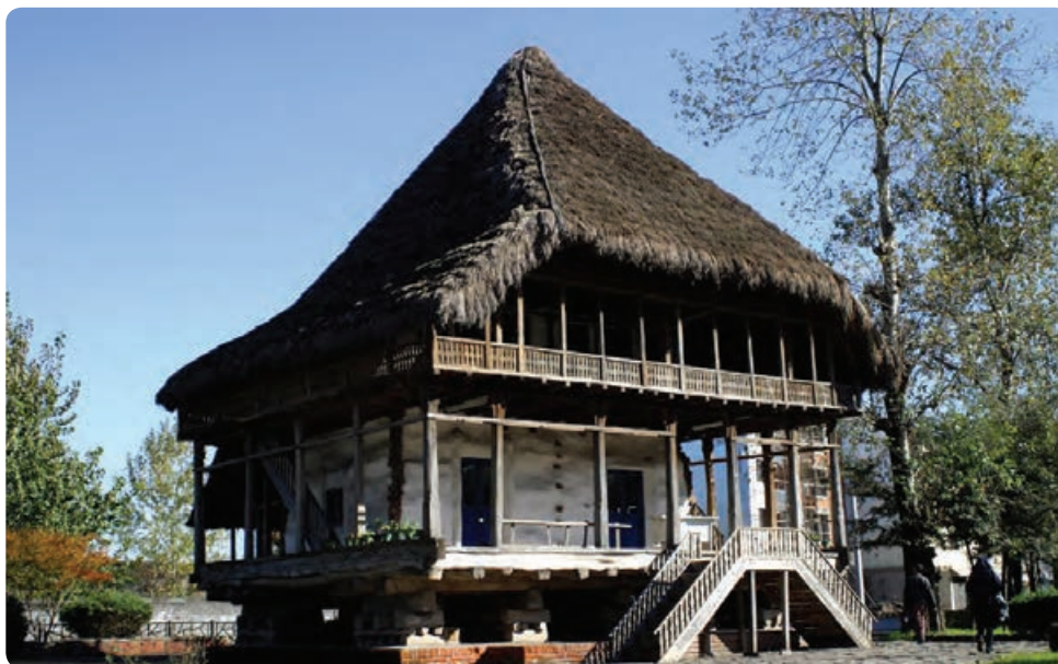
شکل ۲-۷- خانه‌ای با سقف گالی پوش
