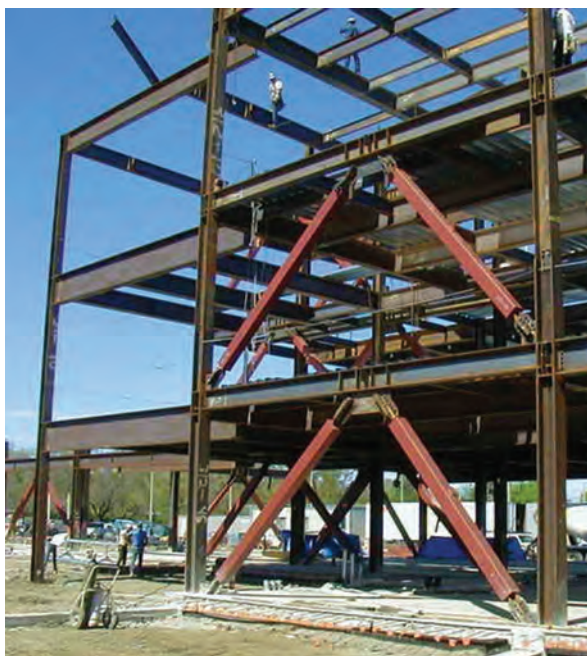
شکل ۵۰-۳- مقاوم سازی ساختمان‌ها در مقابل زمین لرزه
