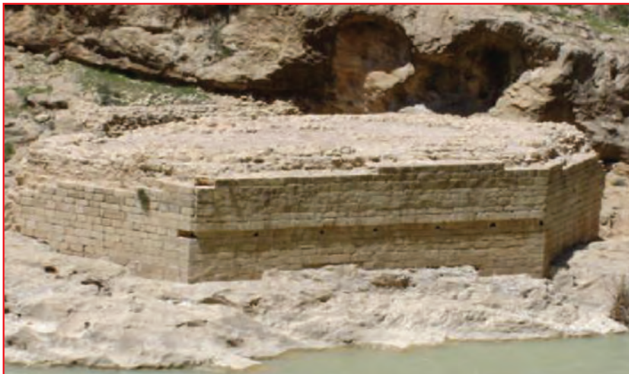
شکل ۳-۴- پایه پل تخت شاه نشین
