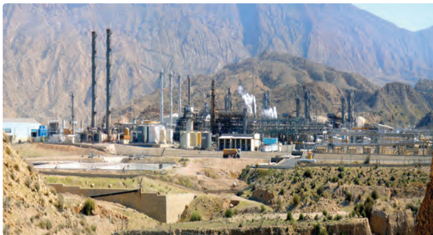
شکل ۱۲-۱۳- تأسیسات گازی پارس جنوبی
