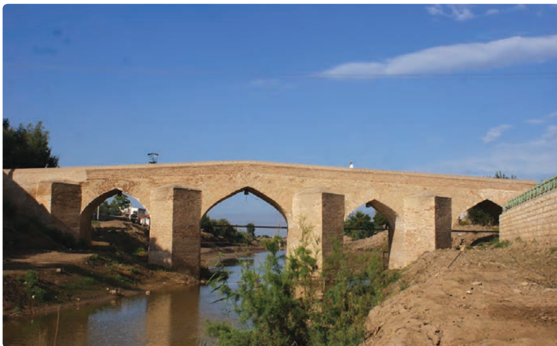
شکل ۱۰-۴- پل تاریخی، دوره صفوی - آق‌قلا
