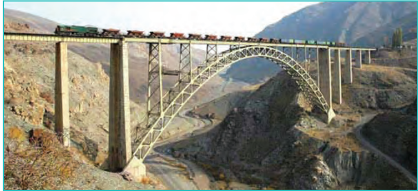
شکل ۶۶-۵- پل هوایی قطور- خوی
