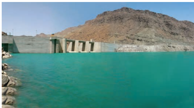
شکل ۲۱-۶- مهار آب های سطحی
