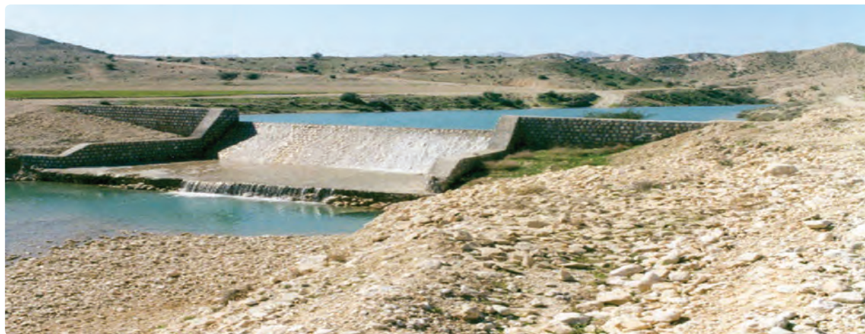
شکل ۱۳-۱۴. احداث استخرهای ذخیره آب
