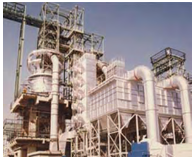
شکل ۲۸-۴- مجتمع فولاد مبارکه
