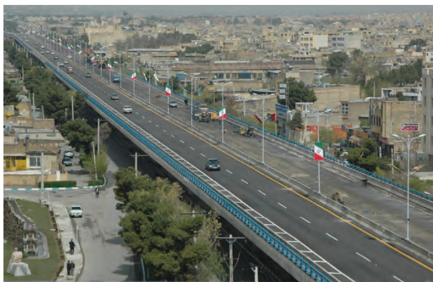
شکل ۳-۷- پل روگذر غیر مسطح امام خمینی (ره)
