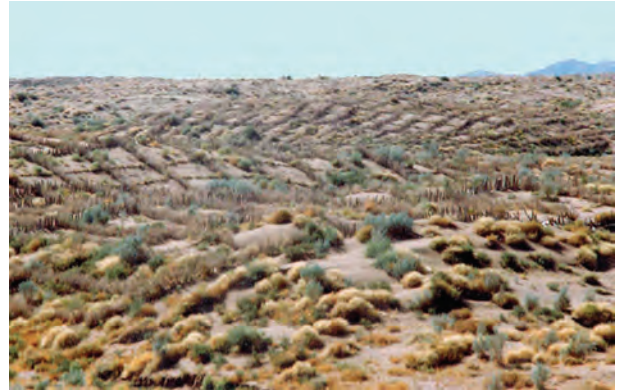
شکل ۴۵-۱ تپه‌های ماسه‌ای بعد از تثبیت (با احداث بادشکن شطرنجی و بندرپاشی)
