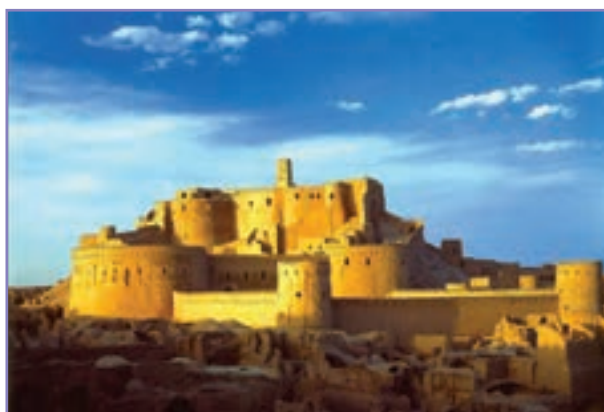
شکل ۳۰-۵- ارگ بم قبل از زلزله
