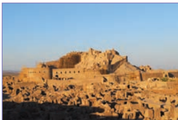
شکل ۳۱-۵- ارگ بم در حال بازسازی
