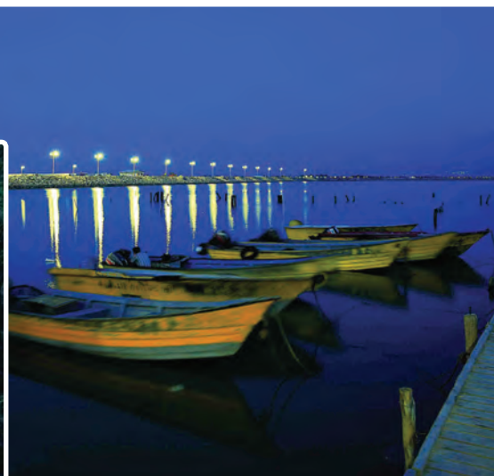
شکل ۳-۵- اسکله بندر ترکمن
