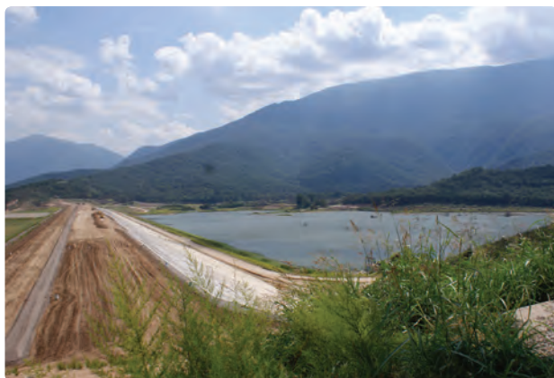
شکل ۴۰-۱- سد زرین گل در جنوب شهر علی آباد
