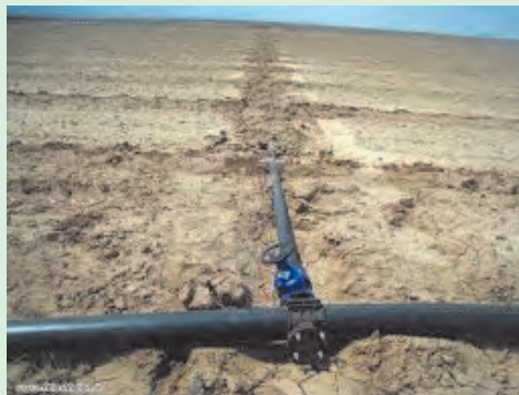
شکل ۴۶-۵. شیر فلکه لوله جانبی
