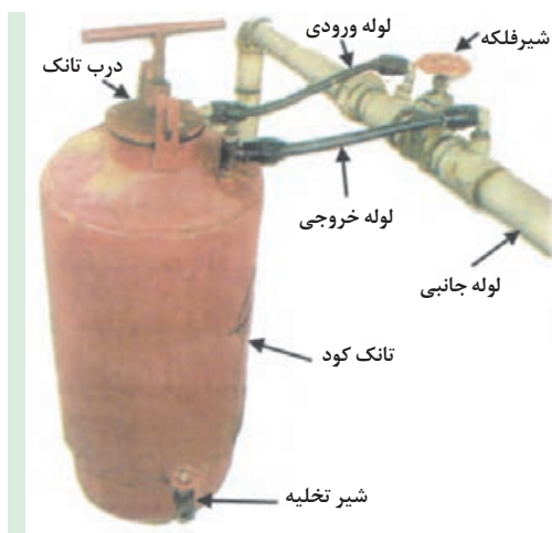
شکل ۴۹-۵. اجزای سیستم توزیع کود
