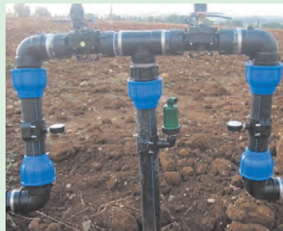
شکل ۳۲-۵. شیر و فشار سنج روی بال ها
