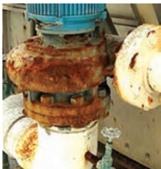
شکل ۵-۵۰- خوردگی الکتروشیمیایی قطعات فلزی
