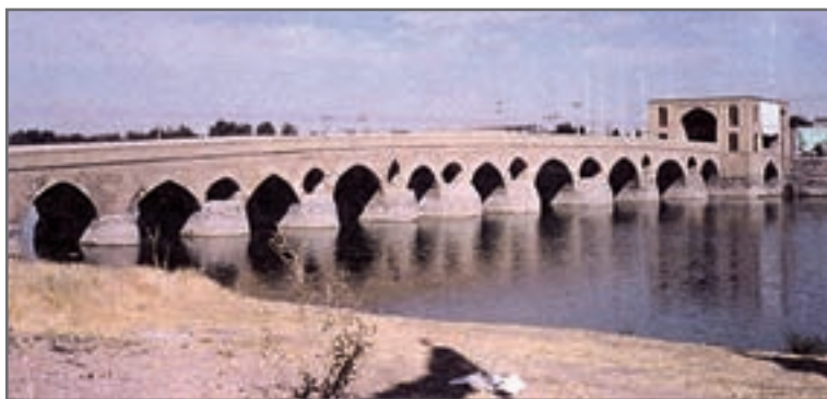
تصویر شماره ۱۹-۴ - پل شهرستان بر روی رودخانهٔ زاینده رود مربوط به دورهٔ سلجوقی
