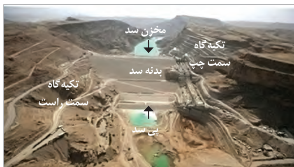
شکل ۴-۵- نمایی از بخش‌های مختلف یک سد
