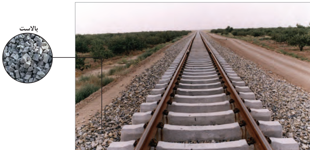
شکل ۴-۱۱- بالاست در زیرسازی جاده ریلی
