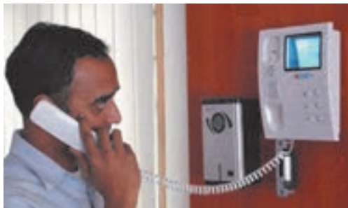
شکل ۱۳- نصب در بازکن
