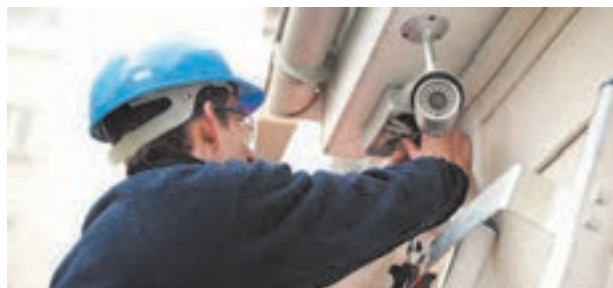
شکل ۲۹- نصب دوربین در فضای مناسب
