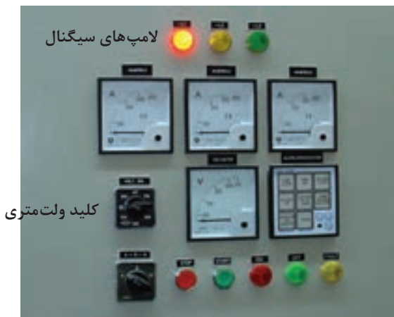
شکل ۷۳- کلید ولت متری و لامپ سیگنال معمولی
