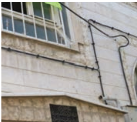
شکل ۲۶ - نصب کابل روی دیوار با بست
