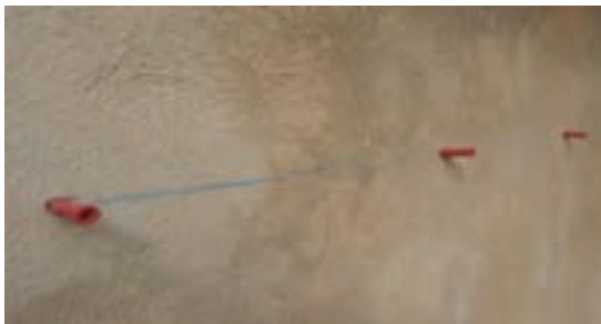
شکل ۳۵- نصب رول پلاک‌ها
