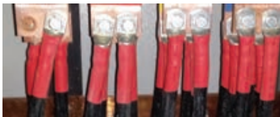
شکل ۱۷- عایق حرارتی کابلشو
