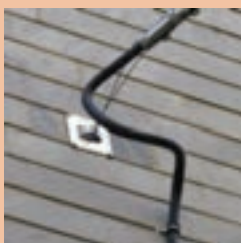
شکل ۵- نصب کابل به دیوار
