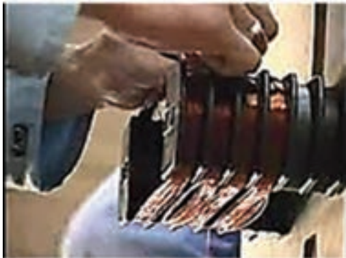
شکل ۳۴- بستن کلاف‌های پیچیده شده روی قالب
