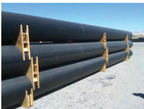
شکل ۱۰-۵- روش‌های مختلف انبار کردن لوله در انبار
