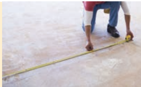
اندازه گیری کف برای تعیین مقدار مواد و مصالح
