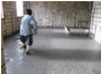
تسطیح فوم بتن قبل از خشک شدن
