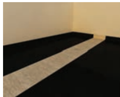
۹- اجرای لایه سوم قیر
