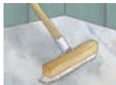
۵- سطح فضا را برای اجرای موکت از گرد و خاک پاک نمایید.
