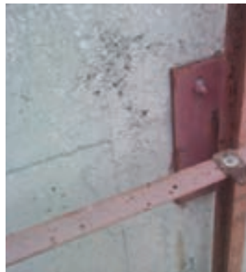
اتصال قطعات زیرسازی سنگ به دیوار
