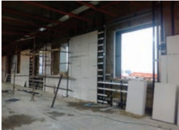
اجرای زیرسازی فلزی
