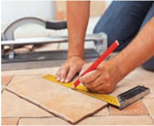
مشخص کردن مسیر برش سرامیک
