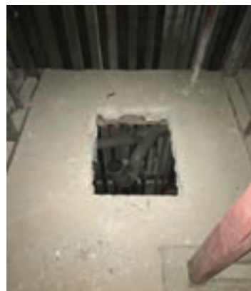
حفره جهت نصب سبد
