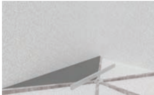
بتن ریزی بین کرم‌ها و تسطیح توسط شمشه
