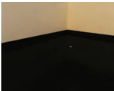
۲- اجرای قیر روی بتن شیب بندی
