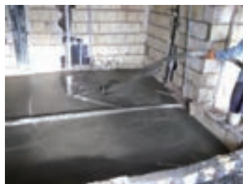
اجرای فوم بتن به عنوان بتن کف‌سازی
