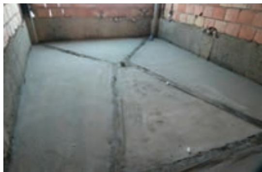
اجرای کرم و بتن شیب‌بندی حمام
