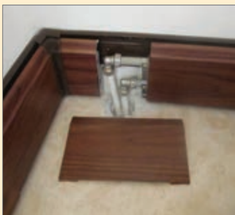
اتصال لوله‌کشی رادیاتور قرنیزی با کاور نهایی
