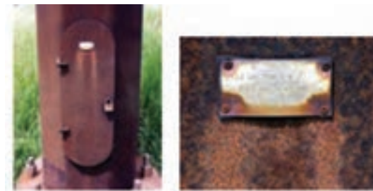
تشکیل پیل گالوانیک به‌دلیل نصب پلاک و قفل از جنس آلیاژ مس روی ستون فولاد کربنی
