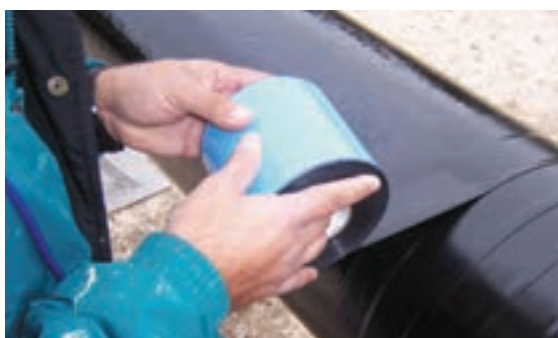
ب) نحوه پیچیدن نوار
