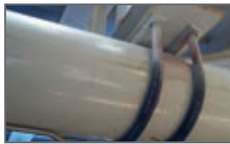
شکل ۱۷- تکیه‌گاه لوله افقی
