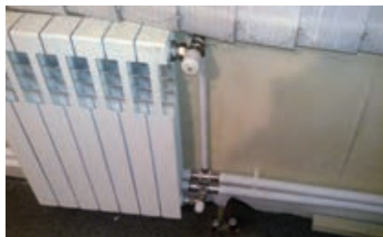
شکل ۶۱- اتصال سر لوله رادیاتور روکار
