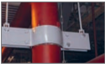
شکل ۱۸- تکیه‌گاه لوله قائم
