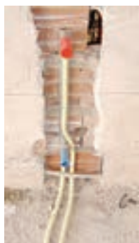
شکل ۶۲- اتصال سر لوله رادیاتور با شابلون زیرکار
