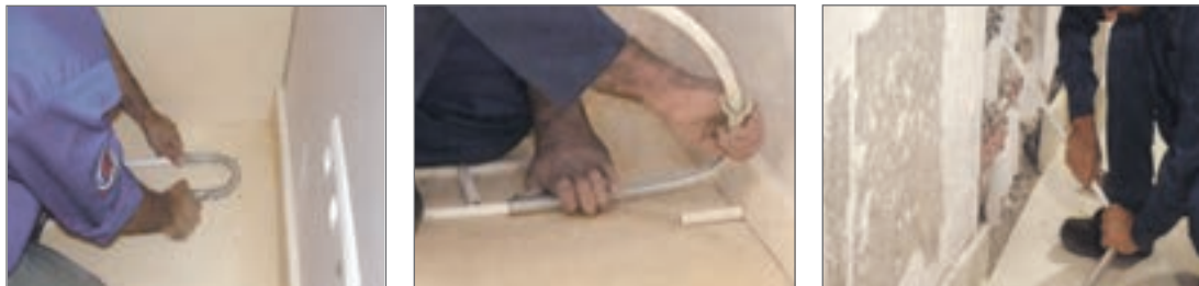
استفاده از فنر برای خم کردن لوله
