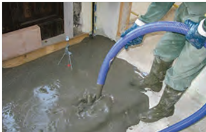
کف‌سازی ساختمان با فوم بتن
