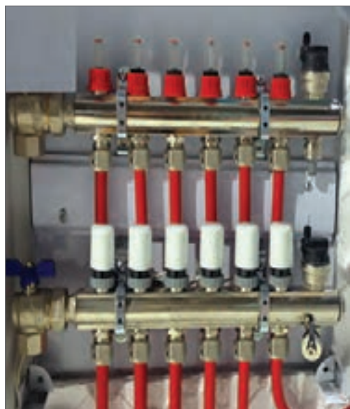
کلکتور سیستم کف گرمایی
