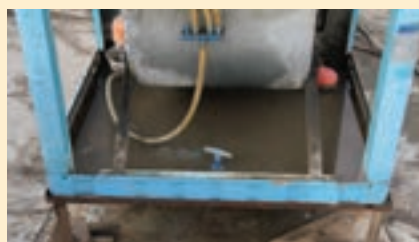
تنظیم سطح آب
