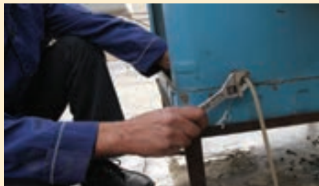
نصب لوله به شیر شناور
