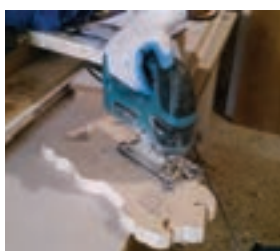
شکل ۱۷- عملیات برش کاری با اره عمودبر
