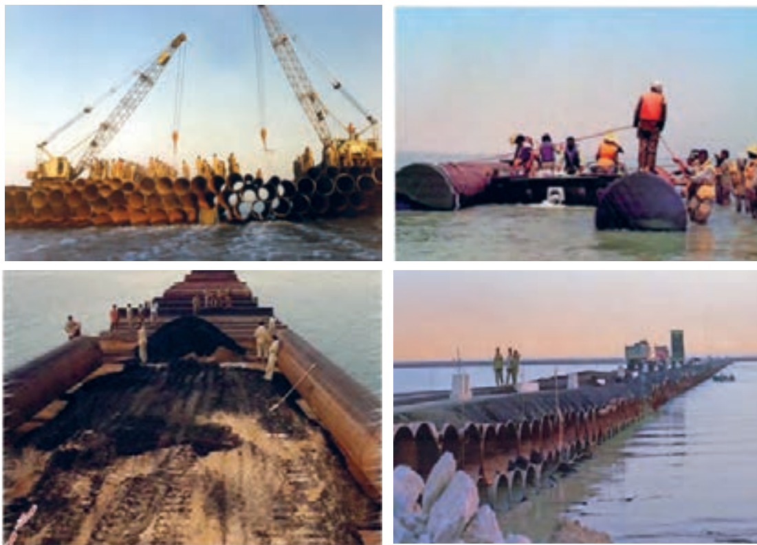
شکل ۲-۵- مراحل ساخت و بهره‌برداری از پل بعثت
