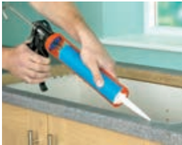
شکل ۱۰۳ - آب بندی لبه های زیرین سینک به کمک چسب آکوارיום
