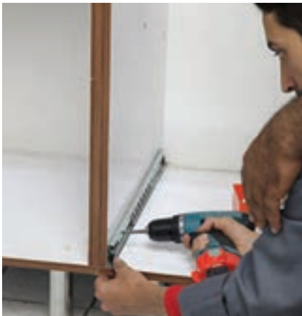
شکل ۸۲ - نصب قطعه یک تکه روی بدنه‌ها
