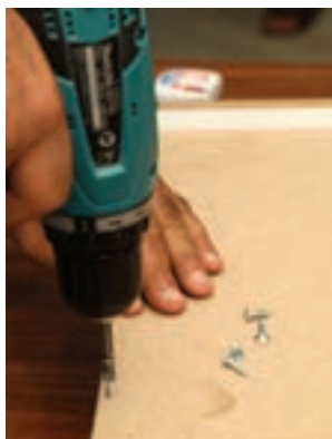
شکل ۵۶ - بستن کف جعبه با پیچ
