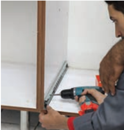
شکل ۸۲ - نصب قطعه یک تکه روی بدنه‌ها
