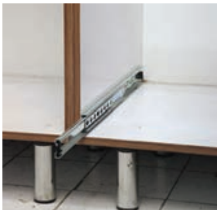
شکل ۸۳ - نصب اولین ریل روی کف و پشت PVC
