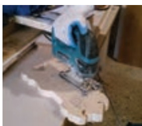
شکل ۱۷- عملیات برش کاری با اره عمودبر
