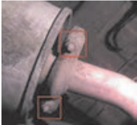
کنترل اتصالات لوله از صدا خفه کن
