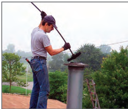
شکل ۲۲- دوده‌زدایی دودکش به روش مکانیکی با استفاده از برس تمیز کننده
