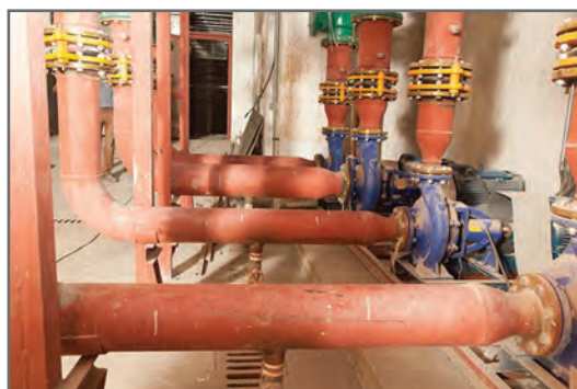
شکل ۳۳- خط مکش پمپ زمینی
