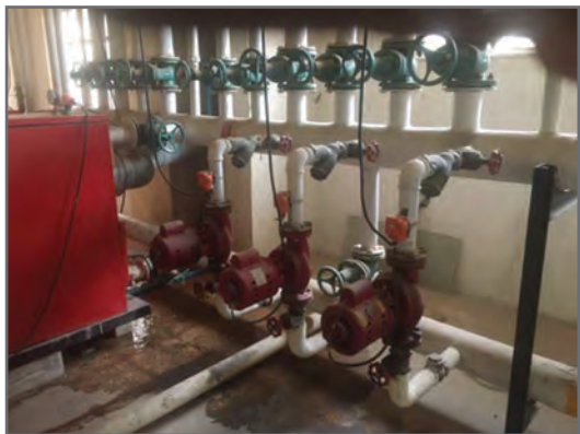
شکل ۱ - پمپ سیرکولاتور سیستم گرمایی
