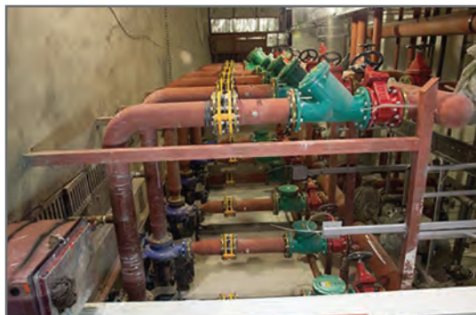
شکل ۳۳- خط مکش پمپ زمینی
