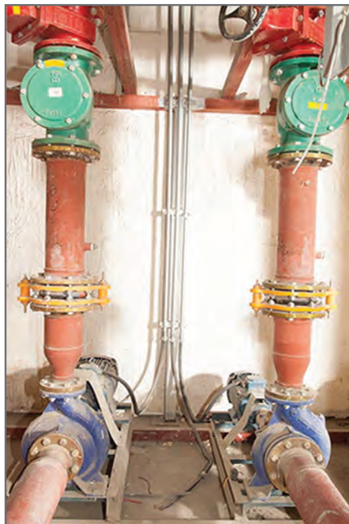
شکل ۳۲ - خط رانش پمپ زمینی
