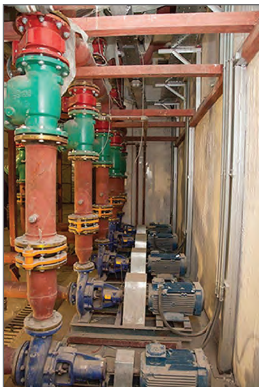
شکل ۳۲ - خط رانش پمپ زمینی
