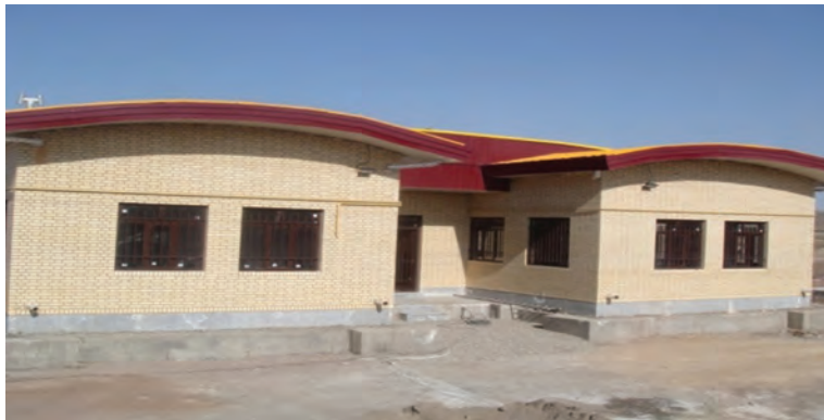
شکل ۳۲ - نمایی از یک راهدارخانه
