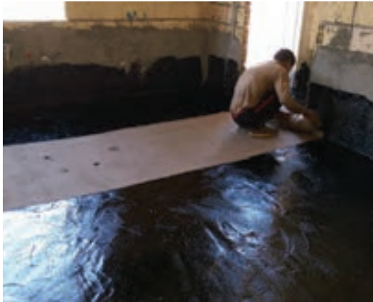
شکل ۱۱-۴- اجرای قیرگونی کف فضای داخلی
