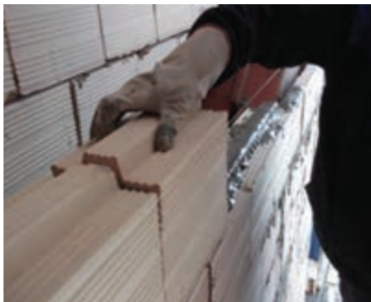
شکل ۴-۵- اجرای بلوک سفالی در امتداد ریسمان
