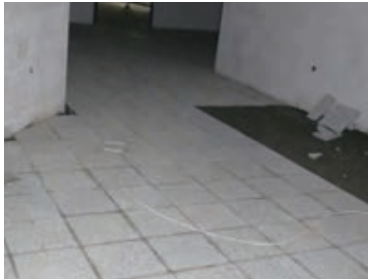
شکل ۲۷-۴- اجرای کف موزائیک در داخل ساختمان
