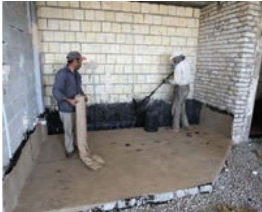
شکل ۱۰-۴- اجرای قیرگونی کف فضای داخلی بر روی دیوار
