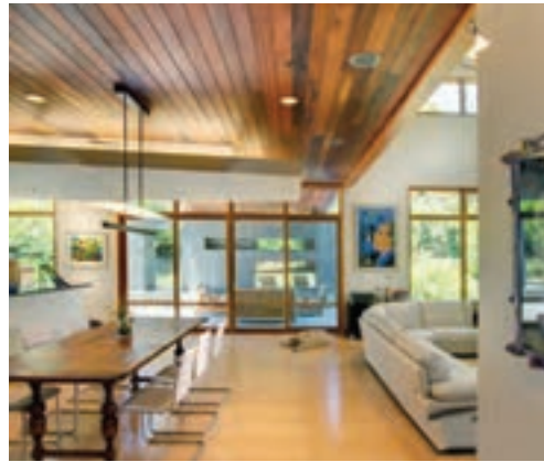
شکل ۲۵-۴- سقف لمبه کوبی شده چوبی
