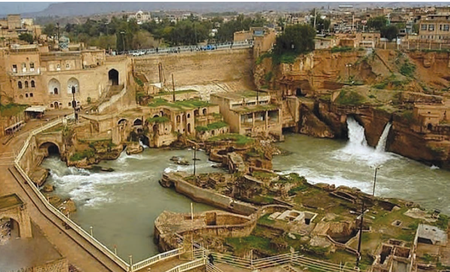
شکل ۵- سازه‌های آبی - تاریخی، شوشتر، خوزستان
