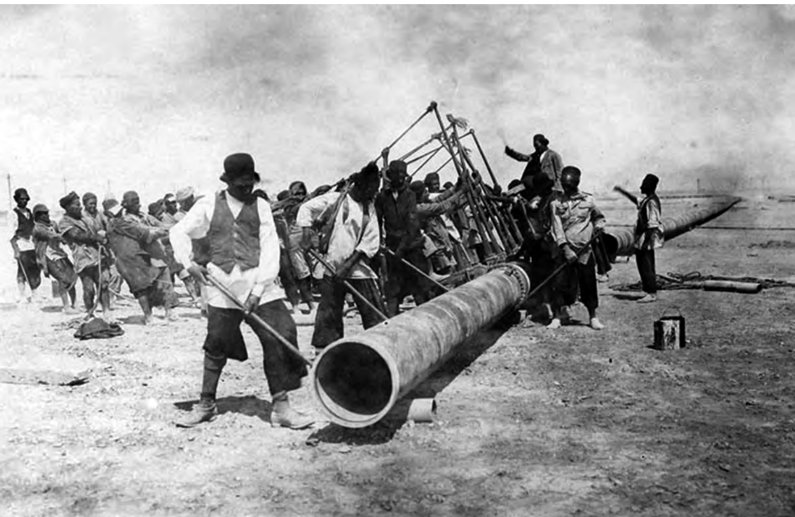
کارگران شرکت نفت هنگام احداث خط لوله نفت در خوزستان
