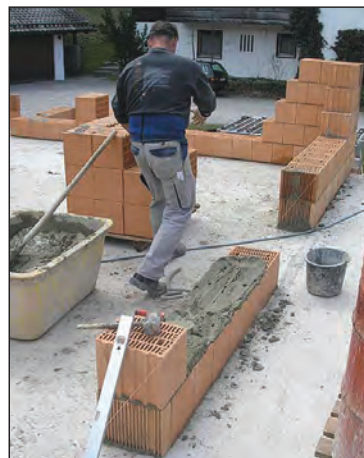
شکل ۱-۱۵۳ ساخت دیوار با بلوک سفالی
