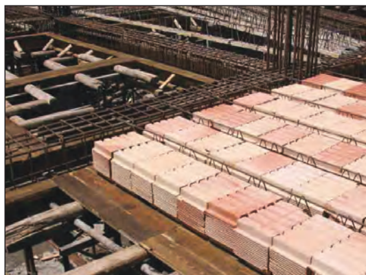
شکل ۱-۱۵۲ کاربرد بلوک سفالی در سقف
