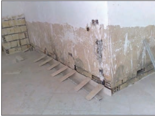
شکل ۹۰-۱ اندود گچ و خاک - گچ سفید پرداختی
