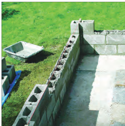
شکل ۱۵۰- ساخت دیوار با بلوک های بتنی یا سیمانی
