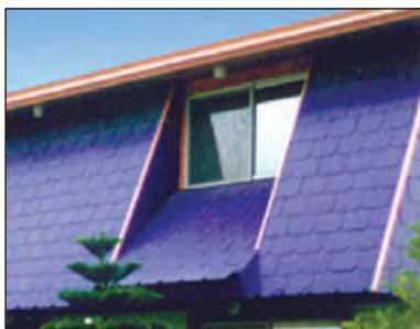
شکل ۴۷-۱ پوشش نهایی سقف شیب‌دار با آردواز
