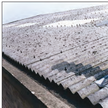
شکل ۹-۱ آزیست (سقف شیب دار)
