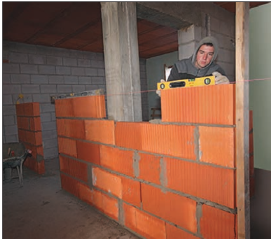
شکل ۱-۱۰۹ دیوار غیرباربر بلوک سفالی
