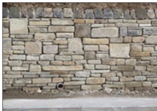
شکل ۱-۱۹۴-دیوار با سنگ کوهی با تراش گونیا شده بدون رج
