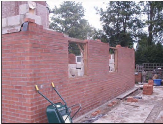
شکل ۱-۱۰۷ دیوار باربر آجری
