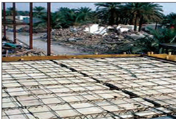
شکل ۱۳-۱ سقف تیرچه بلوک
