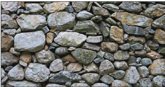
شکل ۱۳۶- دیوار سنگی خشکه چین
