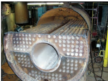
شکل ۴۲-۱ لوله‌ی چدنی دیگ بخار
