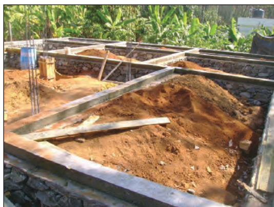
شکل ۲۰۵-۱ بتن ریزی کلاف بندی افقی تحتانی
