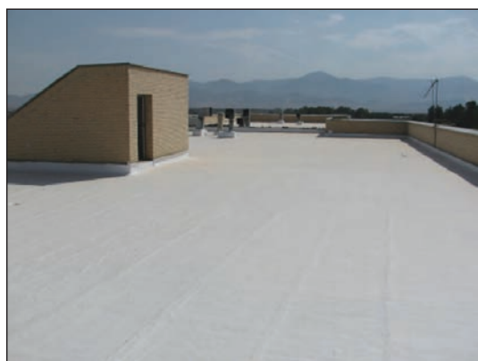
شکل ۱۲-۶ سطح پشت بام
