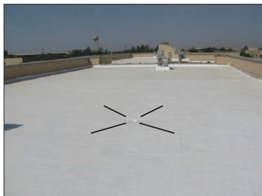
شکل ۱۱-۶ سطح پشت بام
