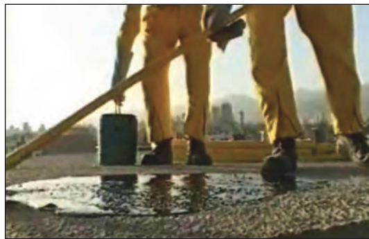
شکل ۲۲-۶ قیرگونی پس از پرکردن بین کُرْم‌ها
