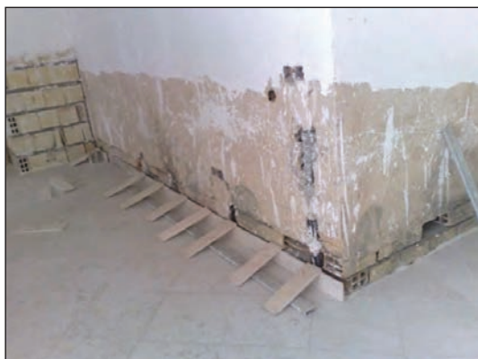
شکل ۱-۹۰ اندود گچ و خاک - گچ سفید پرداختی
