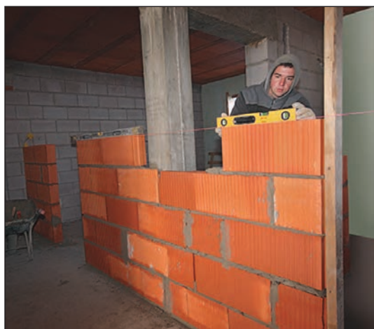
شکل ۱-۱۰۹ دیوار غیرباربر بلوک سفالی
