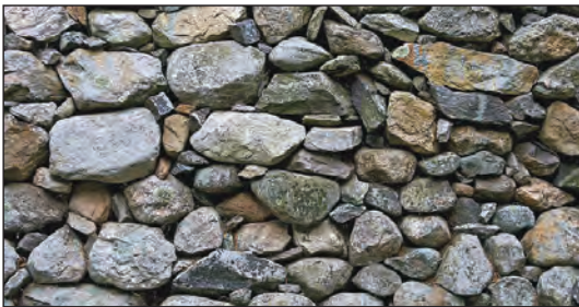
شکل ۱۳۶- دیوار سنگی خشکه چین
