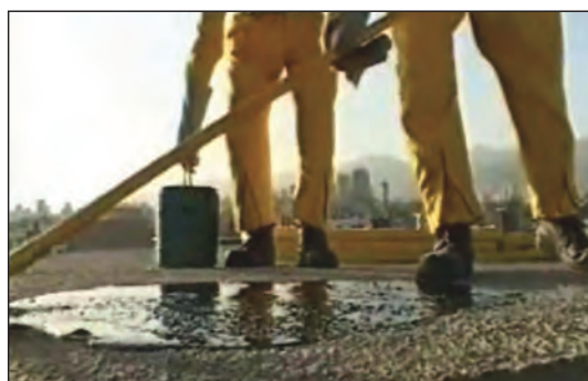
شکل ۲۲-۶ قیرگونی پس از پرکردن بین کُرم‌ها
