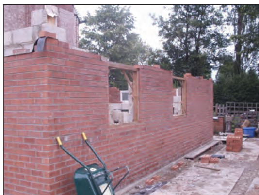
شکل ۱-۱۰۷ دیوار باربر آجری
