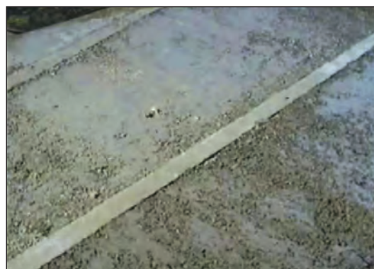
شکل ۲۱-۶ پرکردن فضای بین کرم‌ها با پوکة معدنی
