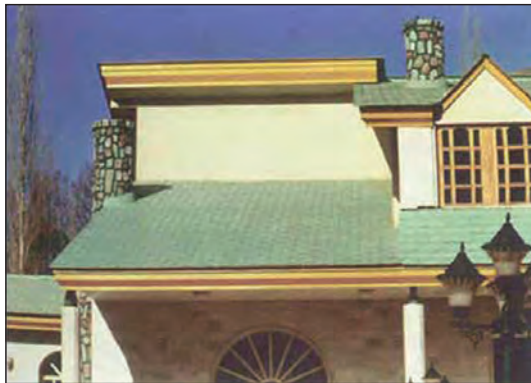
شکل ۱-۱۰۲ پوشش سقف با ورق‌های فشرده‌ی آردواز
