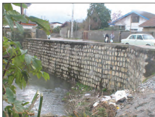
شکل ۱-۱۱۰ دیوار حائل سنگی
