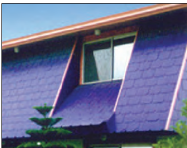
شکل ۴۷-۱ پوشش نهایی سقف شیب‌دار با آردواز
