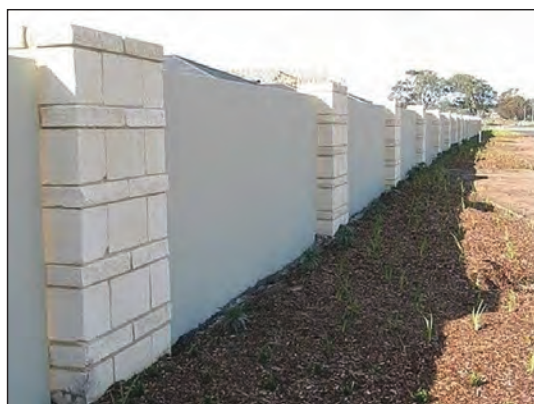
شکل ۱۳۲-۱ دیوار با ترکیب مصلّح سنگ و قطعات پیش ساخته‌ی بتّی
