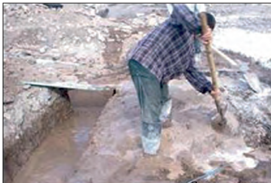
شکل ۱-۳۱ اجرای شفته آهک در فونداسیون
