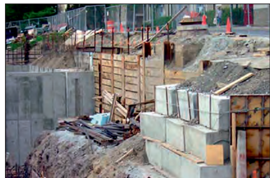
شکل ۱-۹۱ مهاربندی با دیوار مانع چوبی
