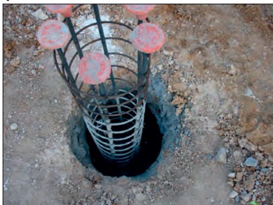
شکل ۱-۷۳ پی چاهی در حال اجرا
