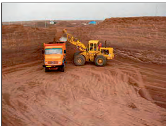
شکل ۸۵-۱ گودبرداری با لودر در زمین نامحدود
