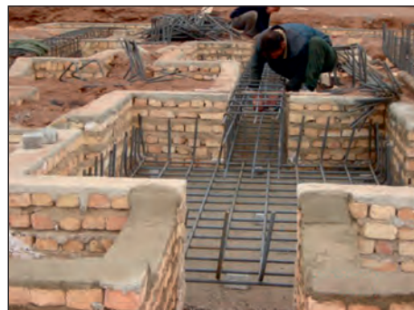
شکل ۱-۸۲ قالب‌بندی آجری در اطراف پی
