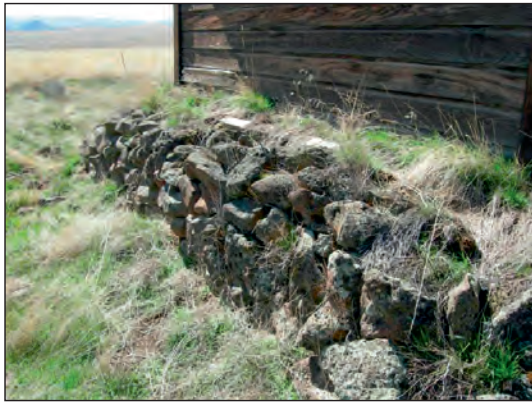
شکل ۱-۳۲ پی سنگی با سنگ لاشه
