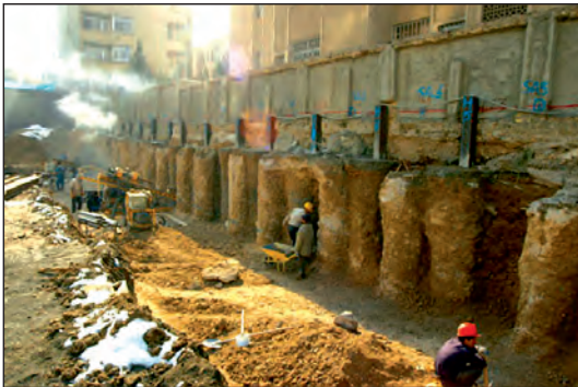
شکل ۱-۸۸ مهاربندی با پشت بند خاکی ستونی
