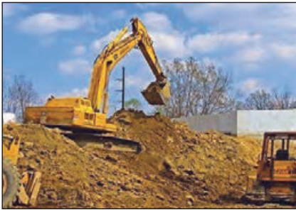
شکل ۱-۱۳- کندن زمین با وسایل مکانیکی
