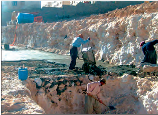
شکل ۱-۸۷ گودبرداری دستی (با بیل و کلنگ)
