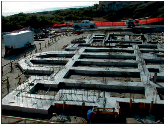
شکل ۵۶-۱ پی بتن مسلح نواری شبکه ای زیرستون
