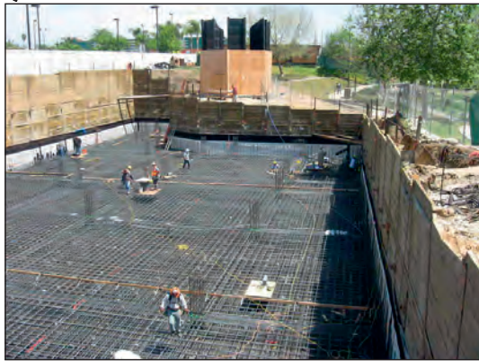
شکل ۱-۶۲ پی بتن مسلح یکپارچه (رادیه ژنرال)
