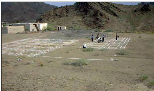
شکل ۸۳-۱ پیاده کردن نقشه روی زمین
