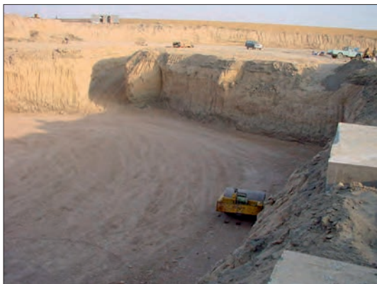
شکل ۸۴-۱ زمین گودبرداری شده
