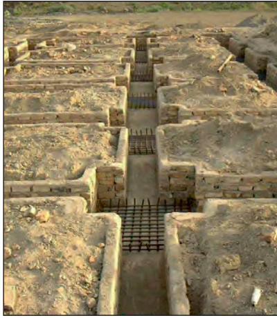
شکل ۴۸-۱ آرماتورگذاری پی تکی کلاف بندی شده
