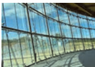
نمای شیشه‌ای با سیستم اسپایدر (سیستم عنکبوتی)
