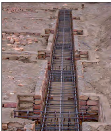
شکل ۷۲-۲ پی و شناژ قبل از بتن ریزی
