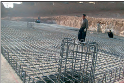
شکل ۱۵۲-۲ آرماتورگذاری پی صفحه‌ای با ستون‌های بتنی
