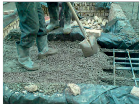
شکل ۲-۱۴۵ مرحله ی بتن ریزی داخل پی
