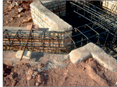
شکل ۲-۱۴۳ آرماتورهای شناژ و پی
