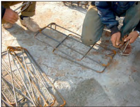
شکل ۲-۱۴۰ خم آرماتور و ساخت خاموت
