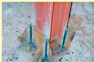
اتصال مناسب و جوش صحیح
