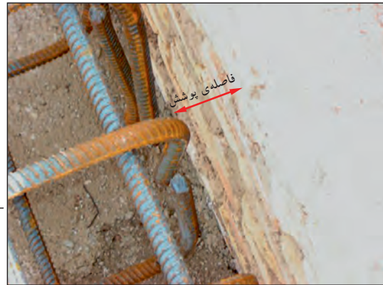
شکل ۱۲۶-۲ فاصله‌ی پوشش و قلاب سر میل‌گردها
