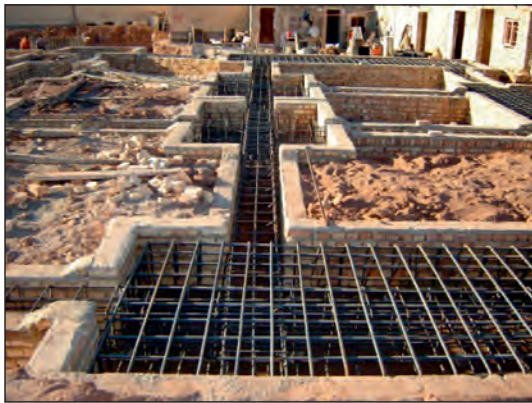
شکل ۷۰-۲ میلگردگذاری در پی کلاف بندی
