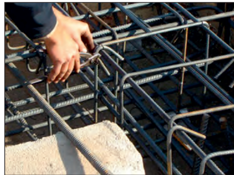
شکل ۲-۱۴۱ بستن خاموت دورآرماتور اصلی شناژ
