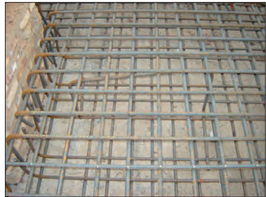
شکل ۱۴۷-۲ پی نواری و آرماتورگذاری آن
