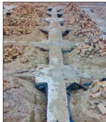
شکل ۷۳-۲ پی و شناژ بعد از بتن ریزی
