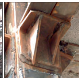
اتصال تیر به ستون به صورت لچکی
