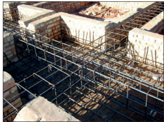
شکل ۷۱-۲ عبور میلگردهای شناژ در پی
