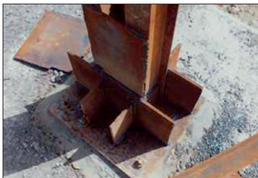
شکل ۱۶۸-۲ اتصال گیردار
