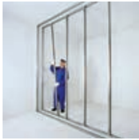
اجرای ردیف اول استاداها
