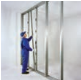
اجرای ردیف دوم استاداها
