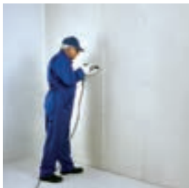
اجرای لایهٔ دوم پانل‌ها
