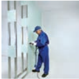
اجرای پانل ها در یک طرف دیوار
