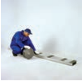
اجرای نوار عایق بر روی استاداها
