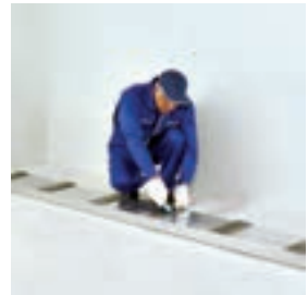
برش نوارهای عایق
